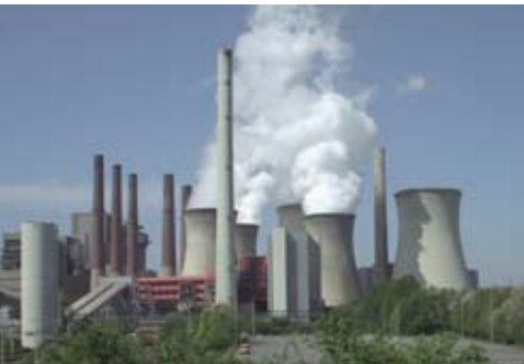
Kühlwasserbehandlung mit Ozon und CO 2
